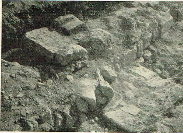
Abb. 6: Südarkade mit Spannmauer (Aufn. F. Behn)
