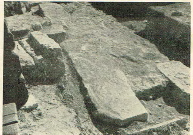
Abb. 7: Westwand der Basilika mit Portalgewände (Aufn. F. Behn)
