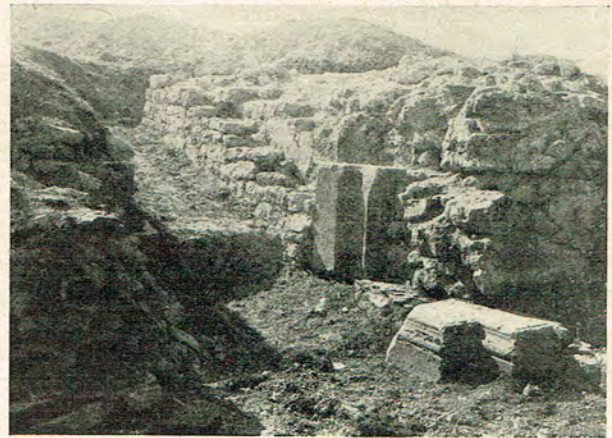
Abb. 14: Nördlicher Kryptenaufgang (Aufn. F. Behn)
